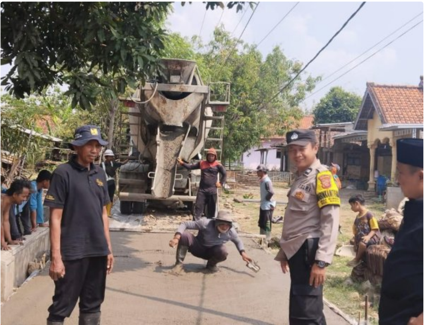
Bhabinkamtibmas Polsek Kroya Laksanakan Monitoring Pengecoran Jalan Di Desa Sumbon
